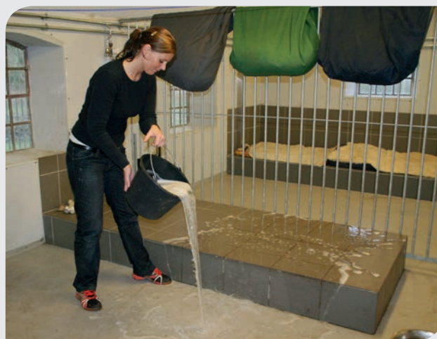
Varmerør kan placeres i en støbt kasse. På den måde får man et opvarmet og hævet liggeleje, mens gulvet stadig er køligt.
